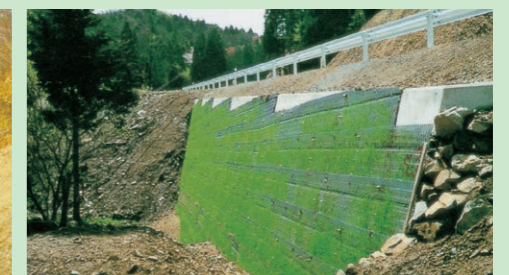
● 笠石コンクリート処理例
