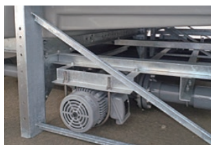
密閉式タワー 散布水ポンプ※2
