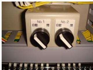
遮断弁の動作を確認する際に、遮断弁電動部の開度表示と弁体指示が合っている事を確認して下さい。（遮断弁動作時に弁体が同時に作動していればOKです）
