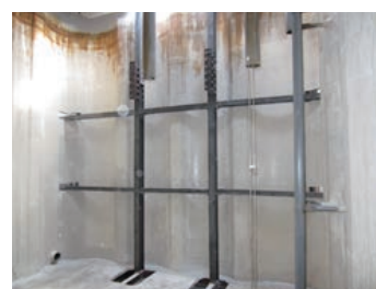
補強フレーム材(外部補強)
