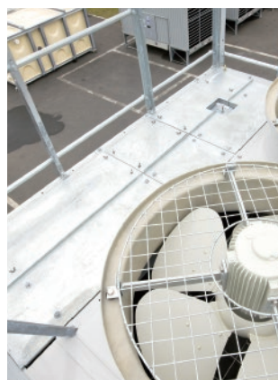
(写真は上部歩廊+散水槽蓋です。)
